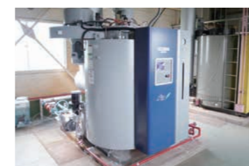
高効率タイプのボイラーへ更新
