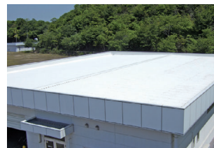
遮熱塗装された屋根
