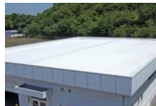
遮熱塗装された屋根
