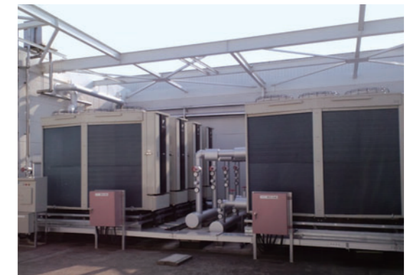
高効率型冷水ヒートポンプチラーの導入 (宇部工場)
