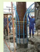
地中熱利用ヒートポンプ の設置
