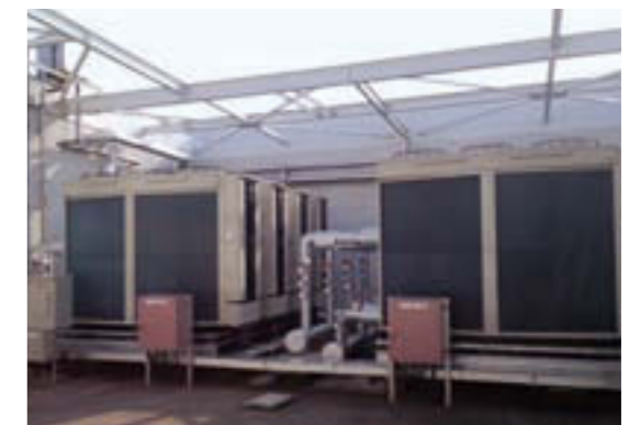
高効率型冷温水ヒートポンプチャラーの導入 (宇部工場)
