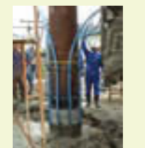
地中熱利用ヒートポンプ の設置
