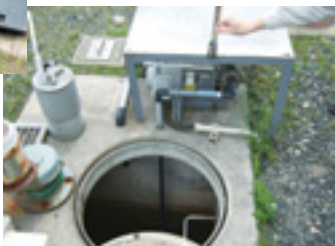
排水の定期測定
