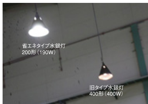
※効果の確認のため工事途中で撮影したものです。
